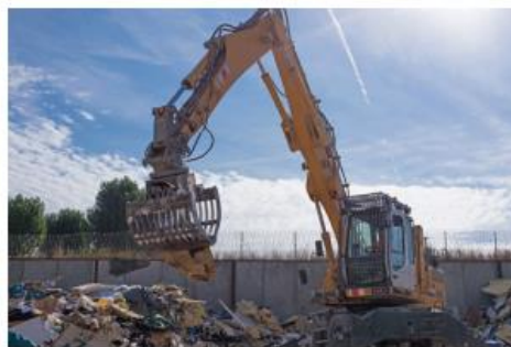
Extraction d'environ 10 % (carton, ferraille, bois) dans un centre de tri/transfert avant évacuation vers des filières de valorisation.
